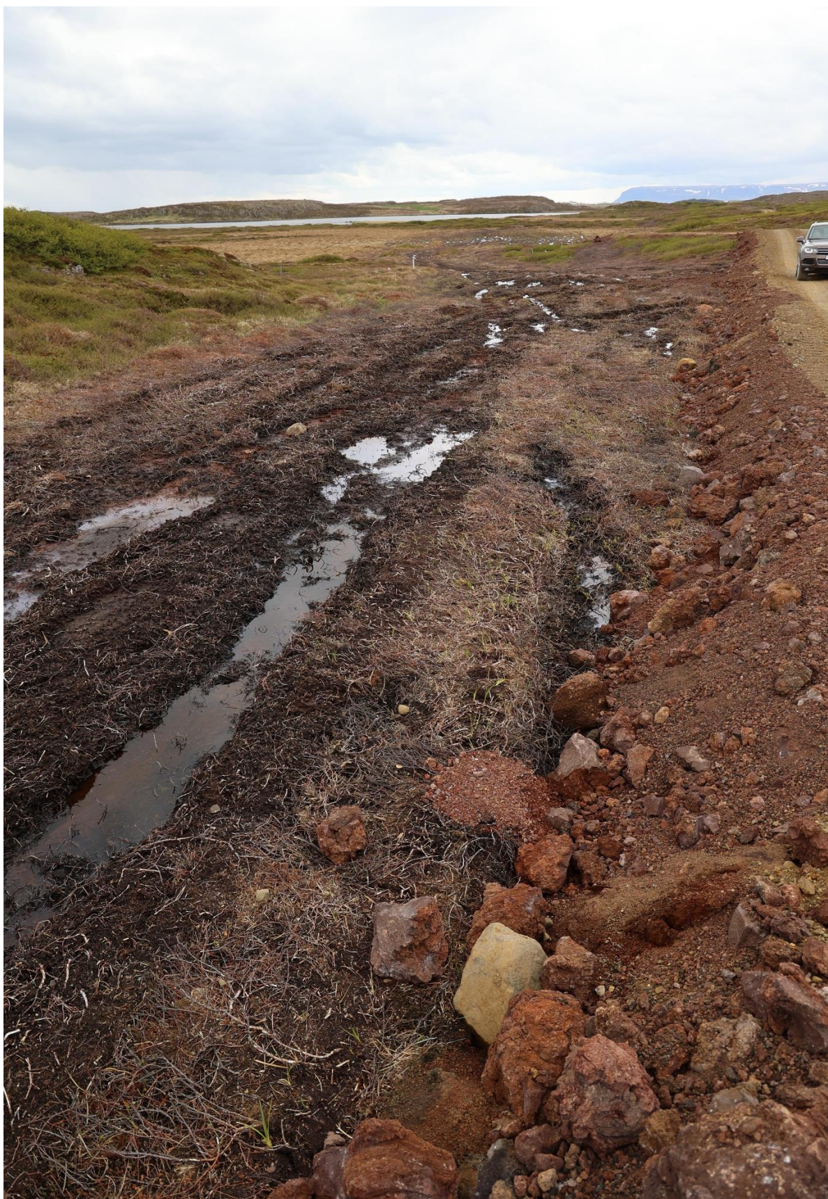
Mynd V11. Vegurinn (kantur lengst til hægri) liggur hér yfir votlendi. Miklu flatarmáli votlendisgróðurs og -jarðvegs langt út fyrir vegstæði hefur verið raskað. Myndin tekin á svipuðum stað og V8-V10. Staðsetning (VOT825): N65.03541° W22.79253°.
