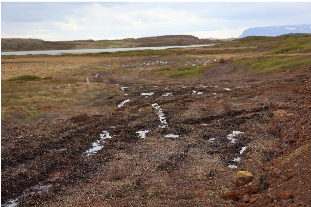
Mynd V10. Vegurinn (kantur lengst til hægri) liggur hér yfir votlendi. Miklu flatarmáli votlendisgróðurs og -jarðvegs langt út fyrir vegstæði hefur verið raskað. Myndin tekin á svipuðum stað og V8 og V9. Staðsetning (VOT825): N65.03541° W22.79253°.
