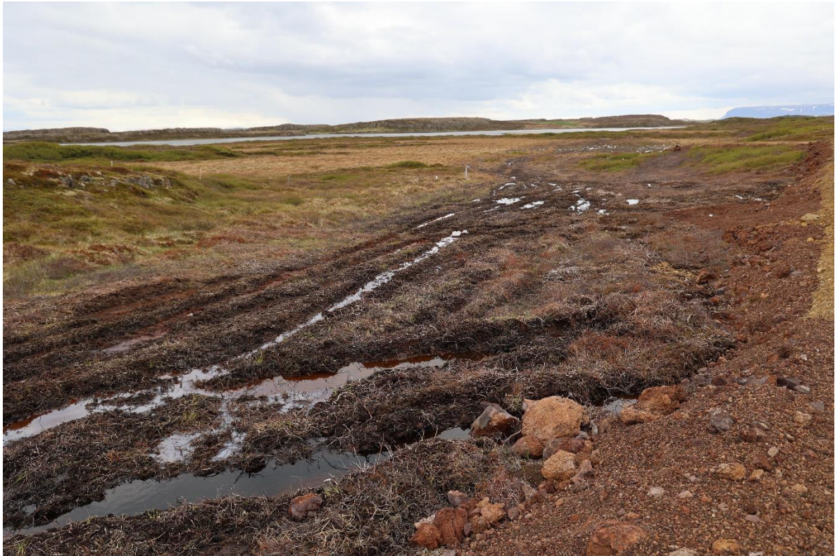
Mynd V9. Vegurinn (kantur lengst til hægri) liggur hér yfir votlendi. Miklu flatarmáli votlendisgróðurs og -jarðvegs langt út fyrir vegstæði hefur verið raskað. Myndin tekin á svipuðum stað og V8. Staðsetning (VOT825): N65.03541° W22.79253°.
